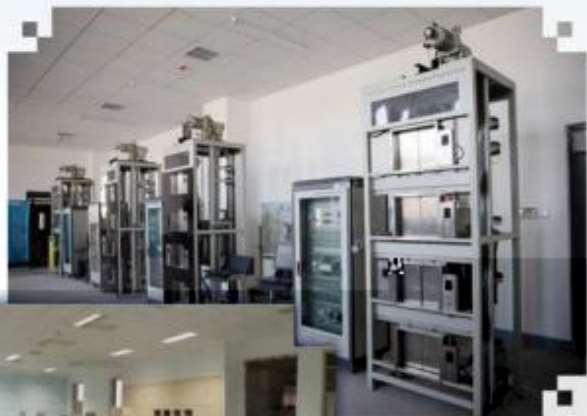
智能电梯安装调试 维护训练场所
